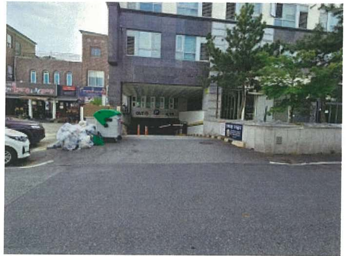
본 건물 지하주차장 출입구
